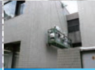
外壁改修工事
